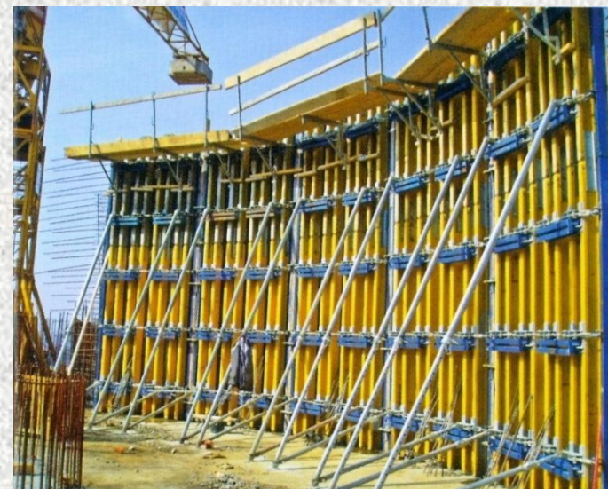
Izgradnja zidova u kružnoj oplati
