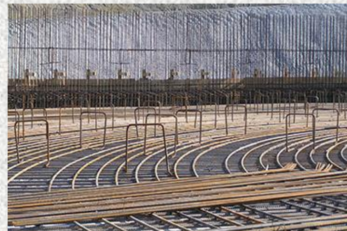
Armatura temeljne ploče
